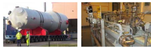
図 2. 撤去した蒸気発生器 (左)
